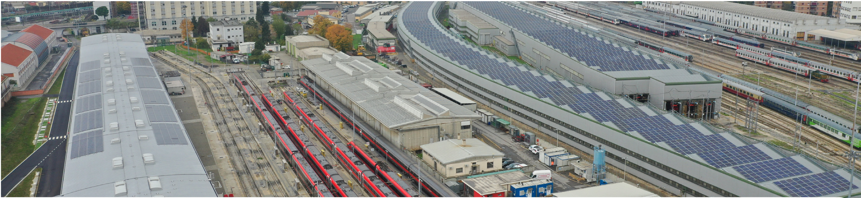
Impianto fotovoltaico di Milano Martesana
